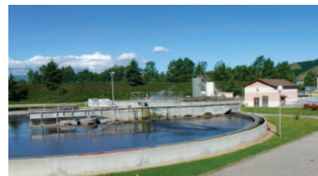
Station d'épuration de Reventin-Vaugris
