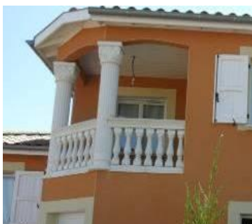
Type de balustres interdits
